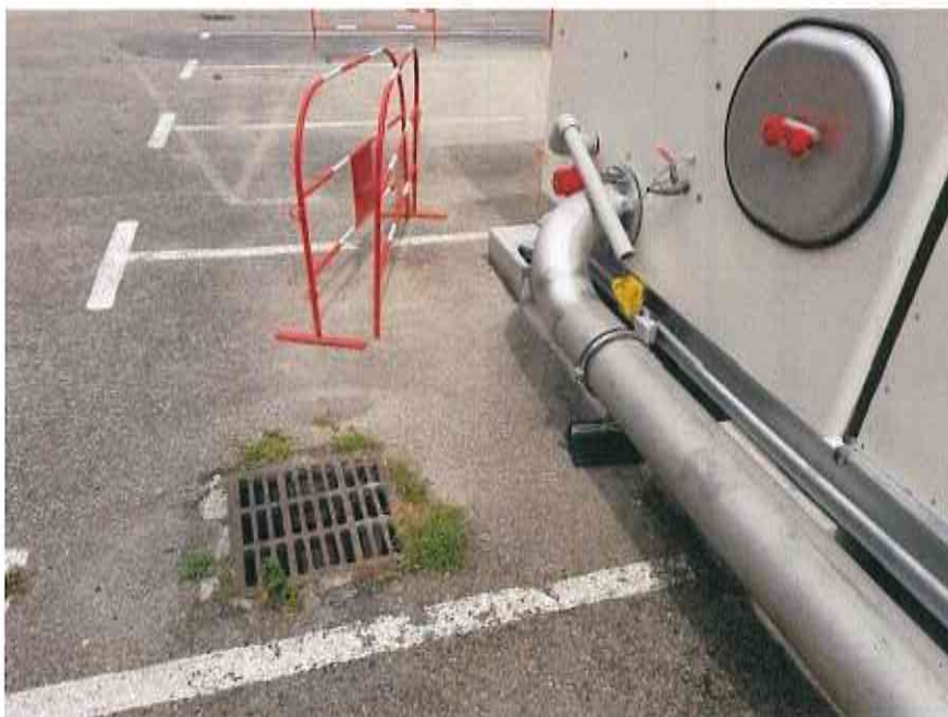
Figure 1: Surverse et regard d'eau pluviale
