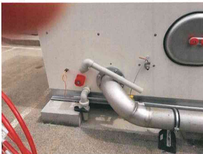
Figure 2: Emplacement des sondes de niveau d'eau
