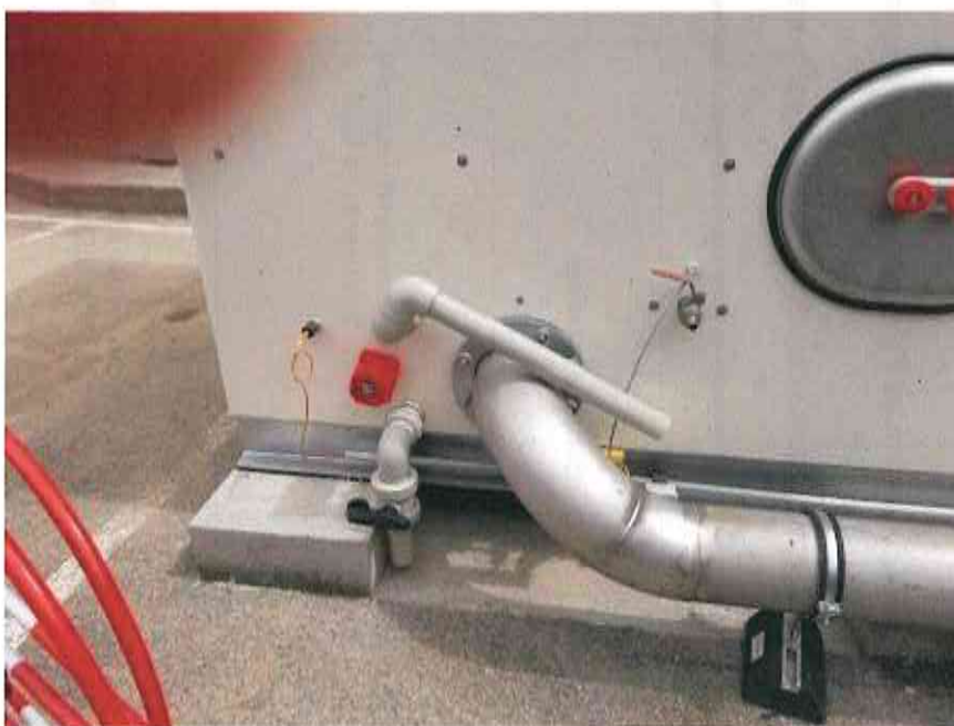
Figure 2: Emplacement des sondes de niveau d'eau
